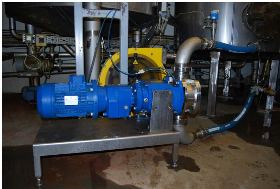
DN100 Syrefast lobepumpe med vertikalstilte anslutninger.
